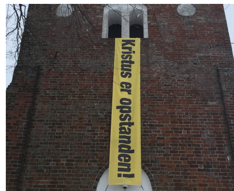
Hillested kirke klædt på til påsken. Foto: Jesper Bacher
